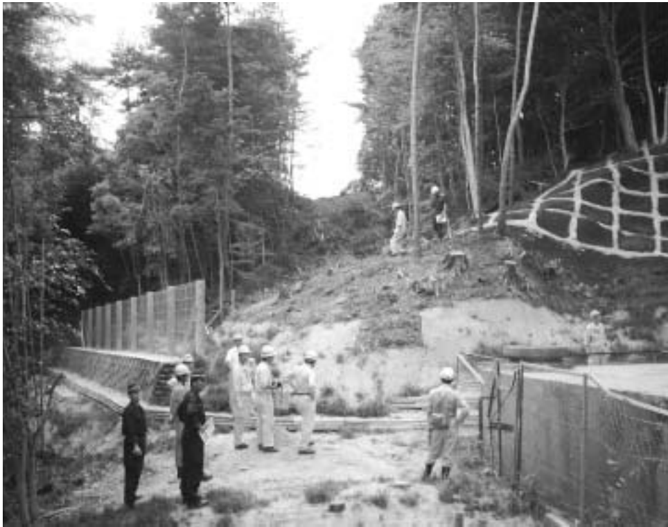
市など防災関係機関による、合同防災パトロールの様子(斜面の崩壊を防止する施設)
