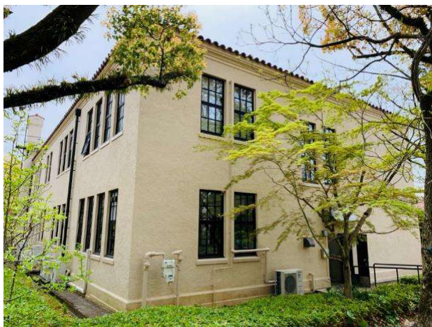
側面写真(北西角)
