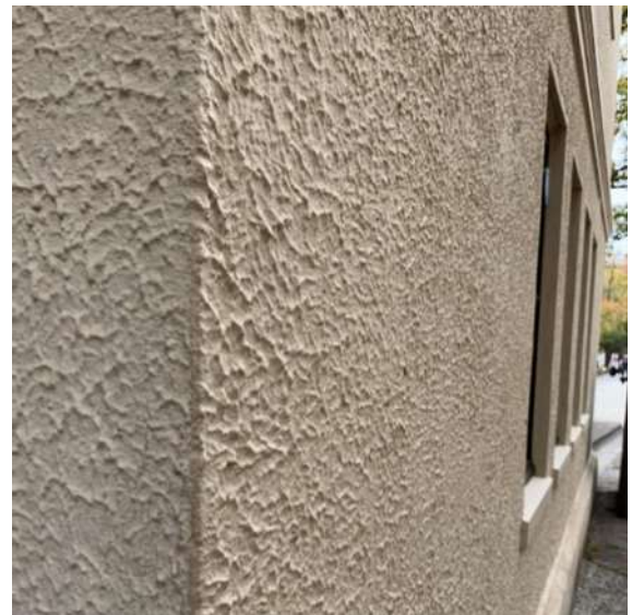
スタッコ引き抜き仕上げの上塗装
