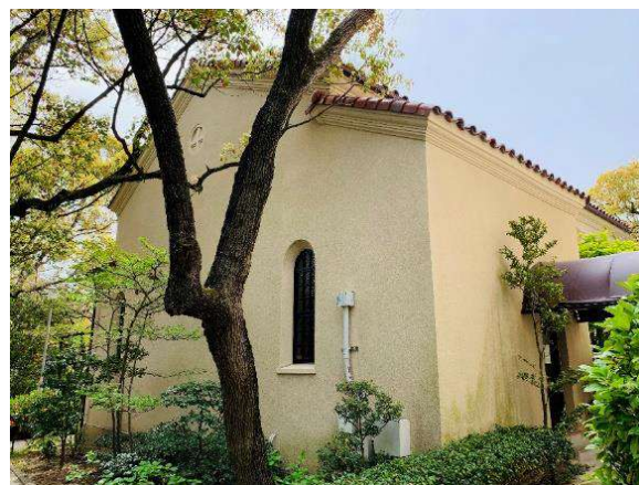
側面写真(北西角)
