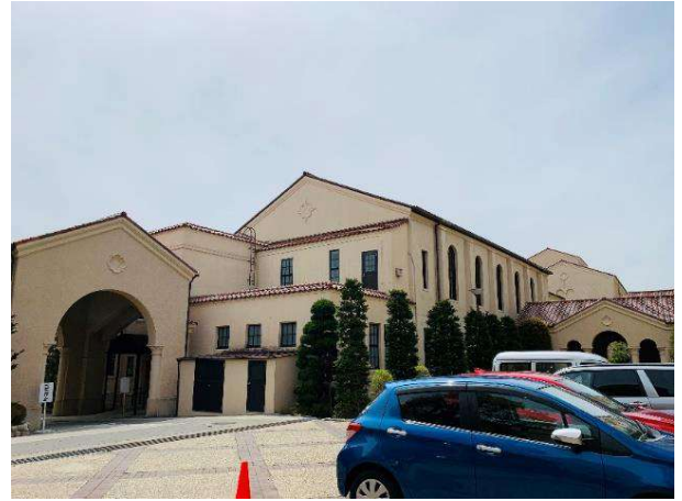
側面写真(北西角)
