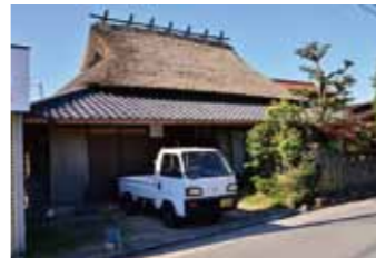
山口町の茅葺き古民家
