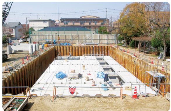
二見公園雨水調整池（地上）
