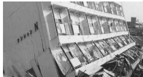
阪神・淡路大震災の被害(安井町)
