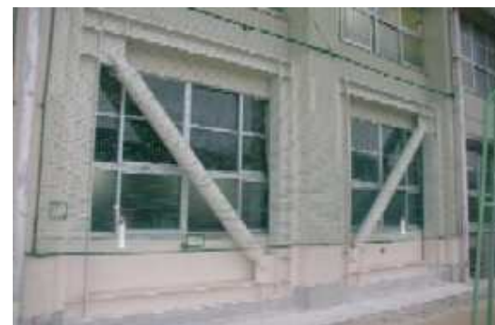
瓦林小学校耐震補強(平成17年度)
