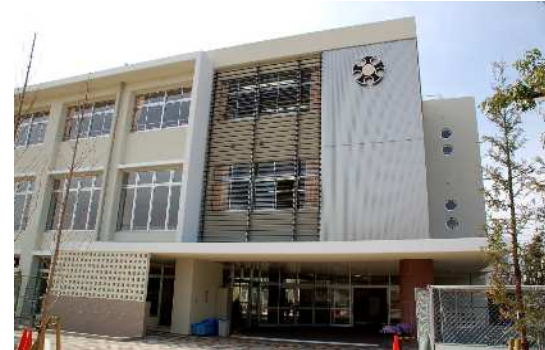
津門小学校校舎改築(平成19年度)
