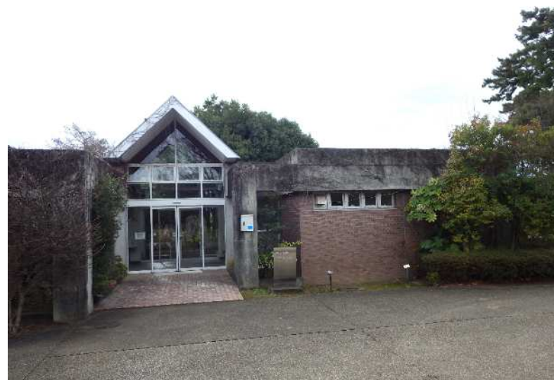
既設の西田公園管理センター外観
