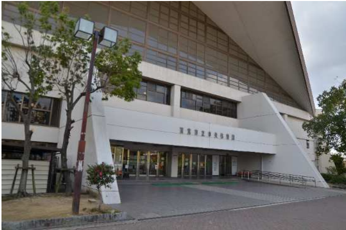
中央体育館現況
