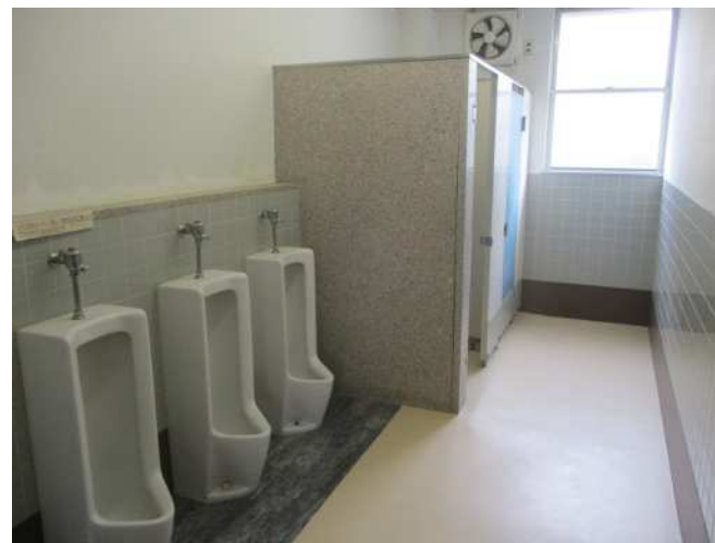
改修後のトイレ
