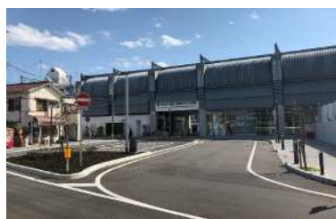
(都) 鳴尾駅前線(鳴尾駅前広場)
