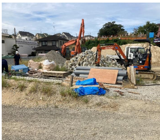
【愛宕山宅地造成工事】
