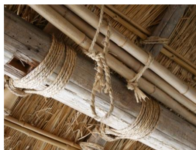
柱や梁は釘を使わずにとめているため解体した後に再利用することができます。
