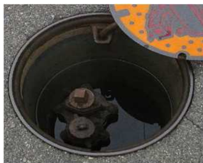
図 1 - 2 9 消火栓設置例
