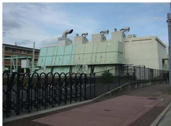
櫛塚ポンプ場
