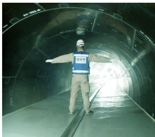
右図：ネットワーク幹線内部（供用開始前）
