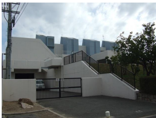
大浜ポンプ場
