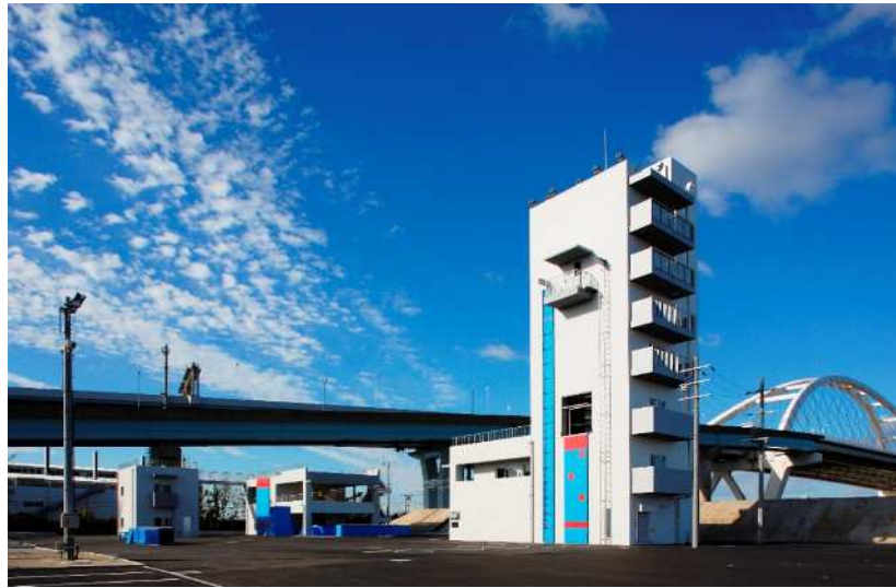
西宮市消防訓練施設
