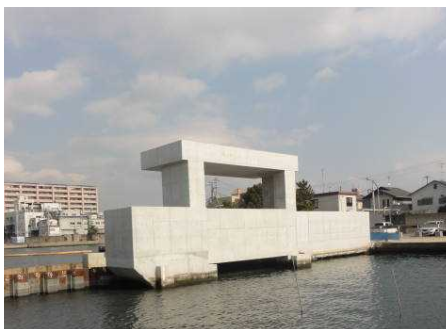
写真 5.12 洗戎川水門(事業中)
