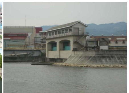
写真 5.14 東川水門(現況)
