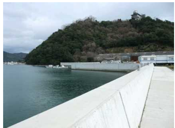
写真 5.1 防潮堤整備(福良港)
