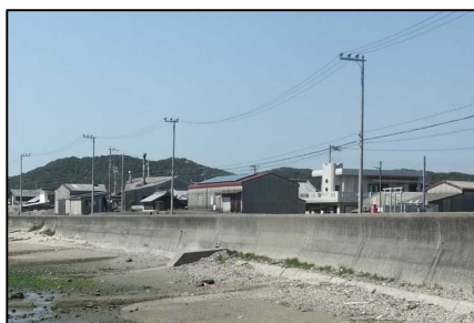
写真 6.3 防潮堤 (着工前)
