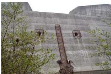
山口地区 東船坂堰堤 土砂捕捉状況
