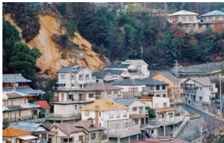
西宮北部でも崖崩れが発生(宝生ヶ丘1丁目)
