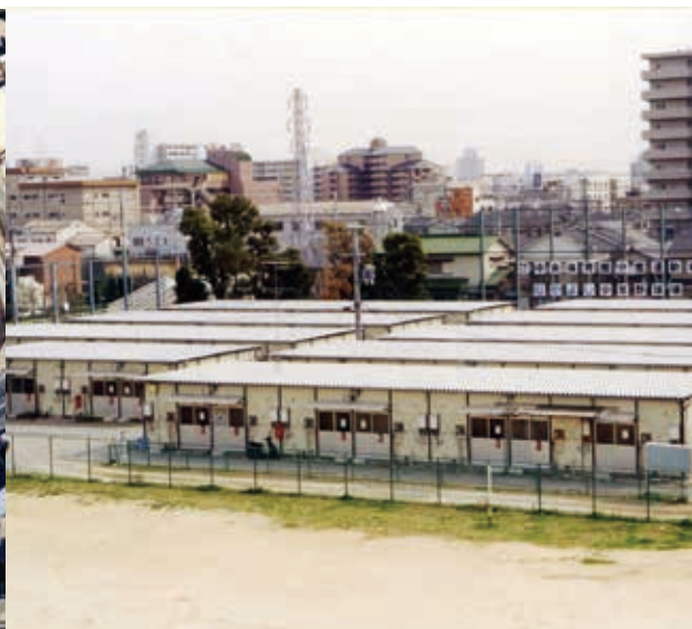
市内各所で仮設住宅が建てられました
