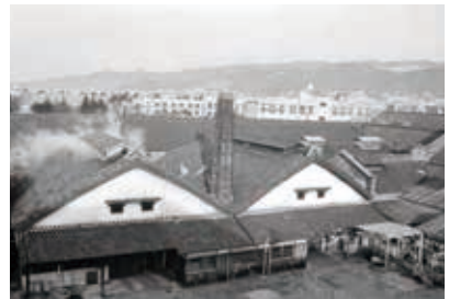
【倒壊前の双子蔵の様子】
