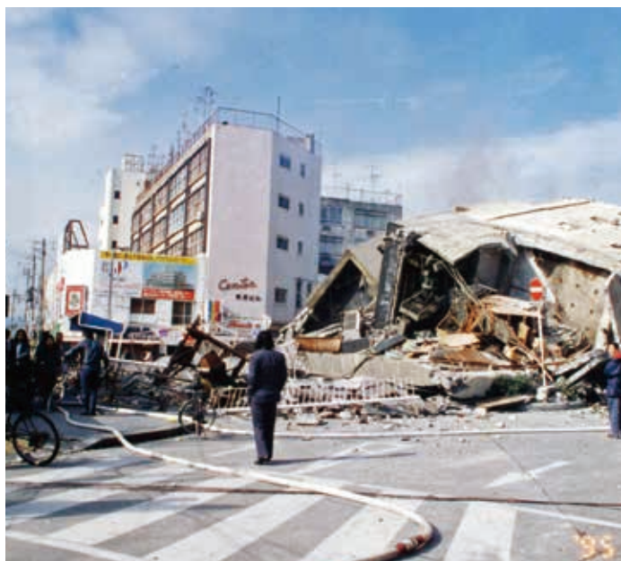
駅前のビルが崩壊した様子
