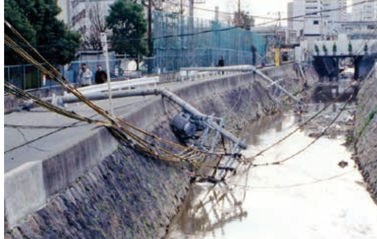
倒壊家屋、倒れた電柱により市内各所で道が塞がれました
