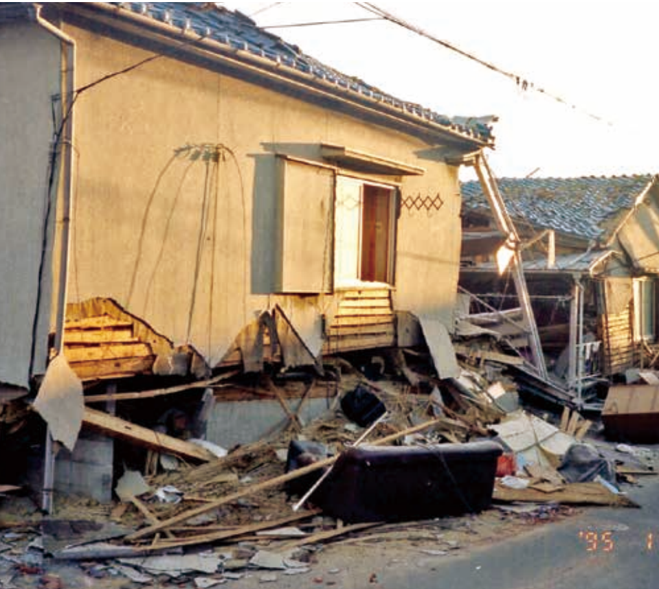
【倒壊した住宅の様子】1階部分が潰れるなどにより、多くの建物が全壊しました
