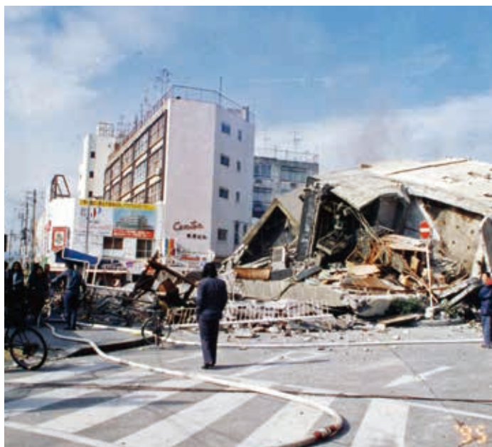
駅前のビルが崩壊した様子
