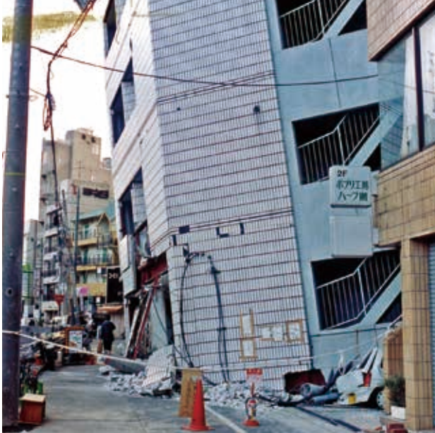
【ビルやマンションの被害の様子】1階部分が潰れて傾いた建物
