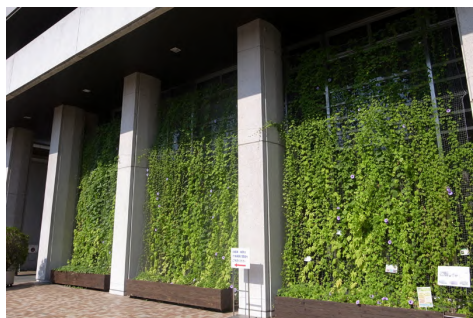
壁面緑化(緑のカーテン)事例（西宮市役所）
