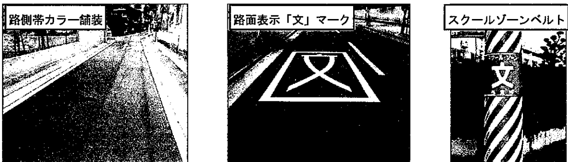
図Ⅲ-2-26 通学路の安全対策の実施例
