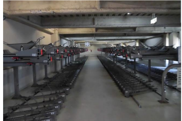
■改修された自転車駐車場
