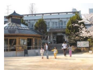
図 5-6 甲山自然環境センター
