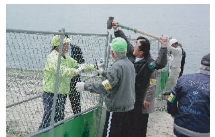
立入制限区域を囲むフェンスの設置
