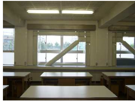
(甲武中学校・北棟 内付け耐震改修後)
