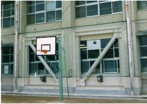
(瓦林小学校 外付け耐震改修後)
