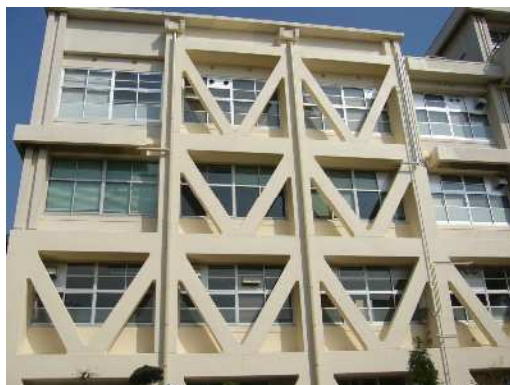
西宮東高校 耐震改修後（ピタコラム工法）
