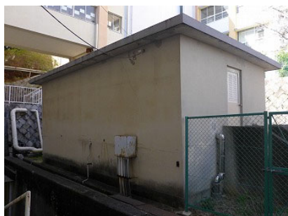
ポンプ室 南東面
