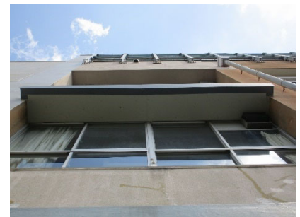
板金改修の箇所
