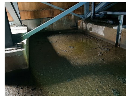
プールピット槽
