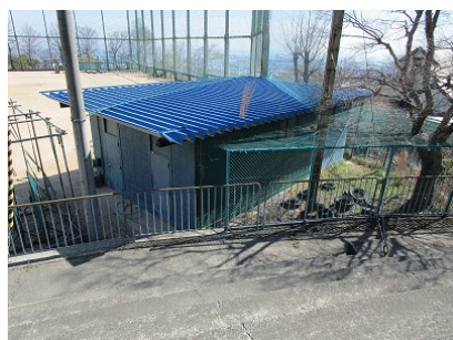
体育倉庫 北西面
