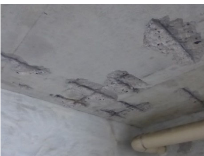
天井見上げ面1
