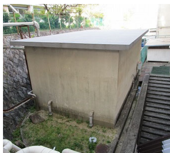
ポンプ室 西面
