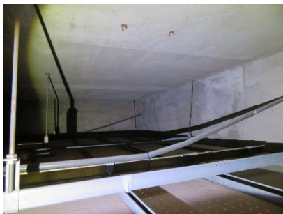
南棟 4階普通教室天井裏
