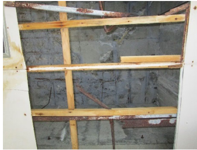
6階便所見上げ面
