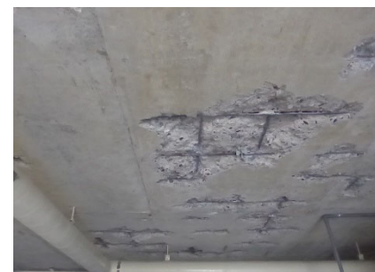
天井見上げ面2
