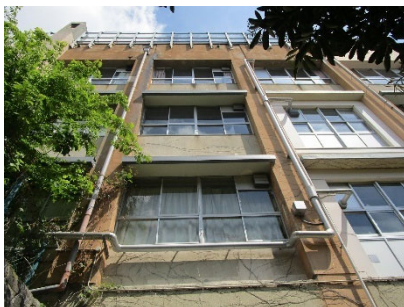
南西棟 南面外観
