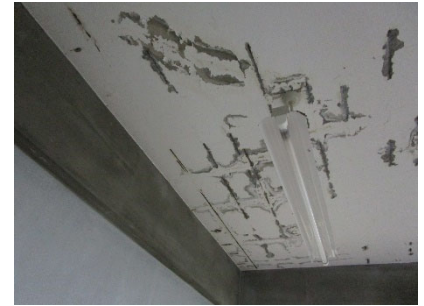
塔屋 機械室見上げ面
